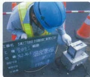
施工中の温度管理
