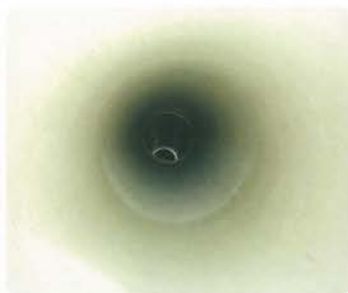
管内面の状況
