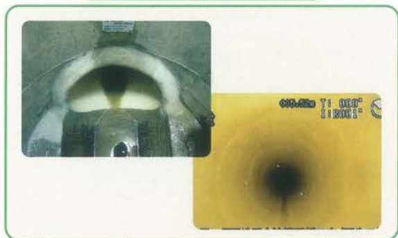
施工後の管内
