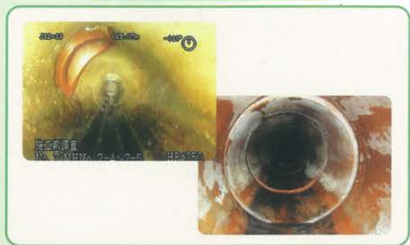
施工前の管内
