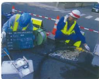
施工中の圧力管理
