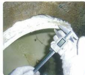
施工後の厚み測定
